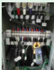
写真1: 電流測定をしている様子
