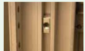
写真4: 狭い溝にクッションナットを差し込んだ様子
