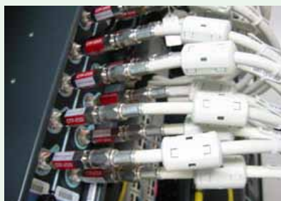
図3: CTF-25S を CMTS に実装した様子
