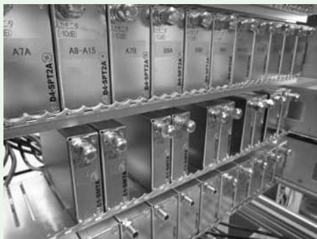
東芝テクノネットワーク製の高密度形ヘッドエンド分配・混合器
