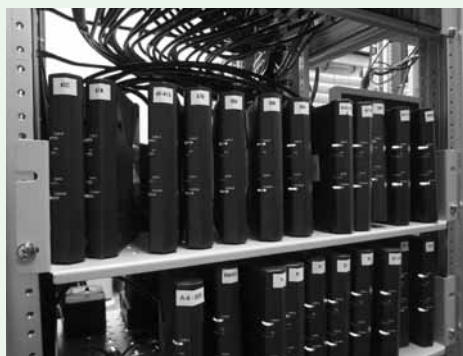
ノードごとのモニター調査やノード分割に使用しているモデム群
