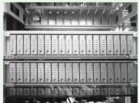
18個のスイッチ型アッテネータを実装したレベル調整器
