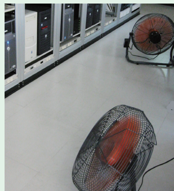
写真3:エアコン停止時に使用
