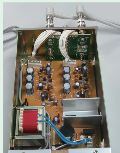
写真2: 分配器の内部
